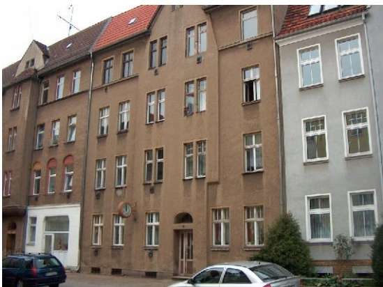
Schöpfurter-Straße 19 Sanierung bis Ende 2026
