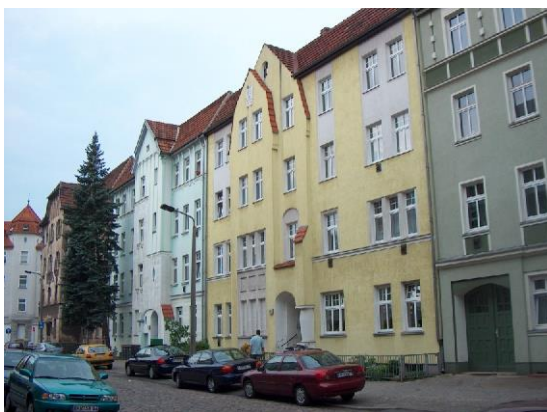
Blick in die Schöpfurter-Straße 16, 18, 20 – vor Sanierung Sanierung von 2022-2025
