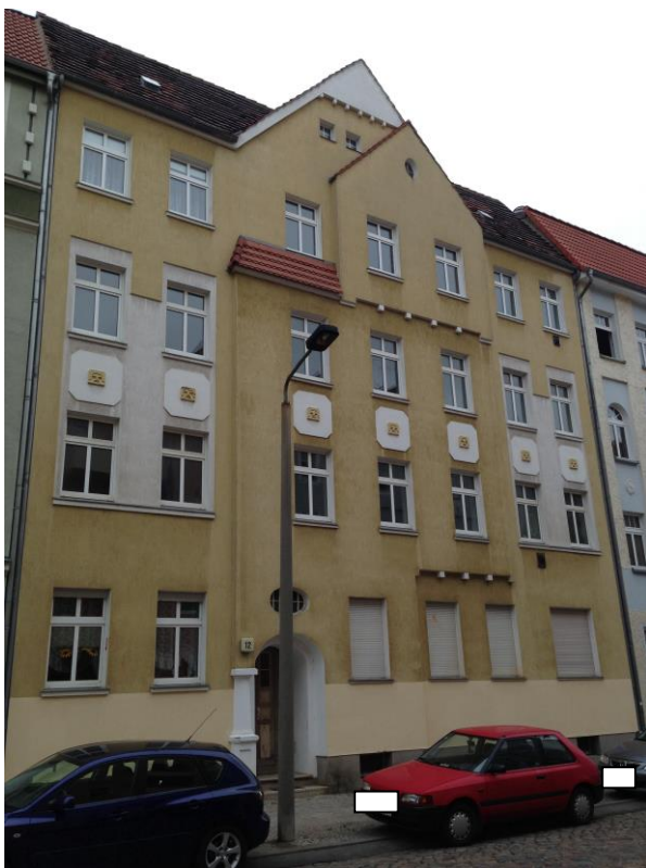
Schöpfungstraße 12 vor Sanierung
