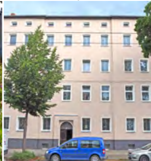
Während der Sanierung
